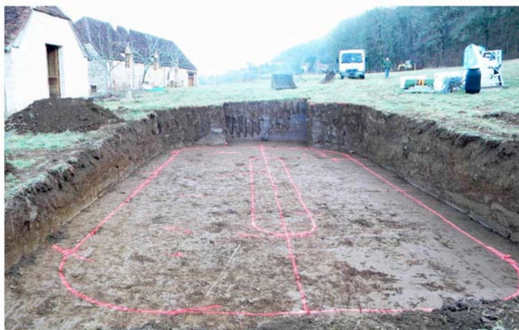
Figure n° 5 - Trou creusé pour la construction de la piscine.
