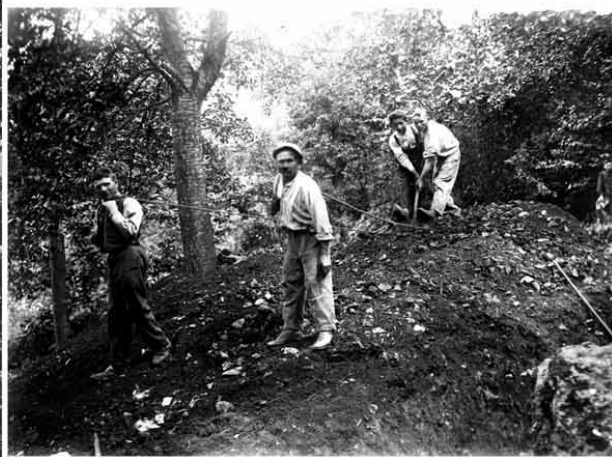
Fouilles de 1922, La manœuvre du "boutaban" où expulsion rapide des déblais vers la pente. Le premier arbre de gauche est sur la galerie Cessac de 1665. A droite on voit la sortie de la tranchée de 1922.
